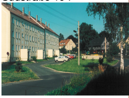
Eigentumswohnung in der Südstraße 19 F
